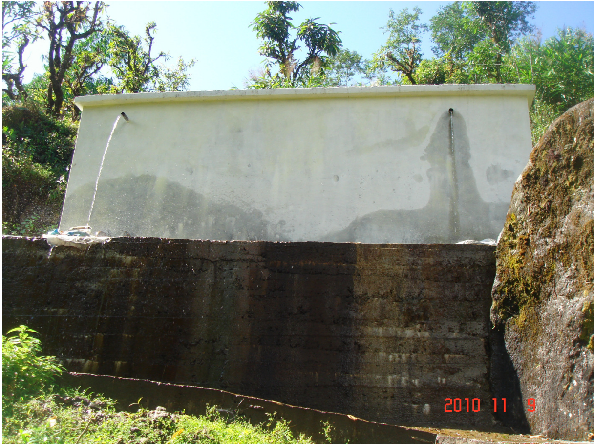
Bild 4 : Neues Wasserreservoir oberhalb des „Girls-Hostel“.
